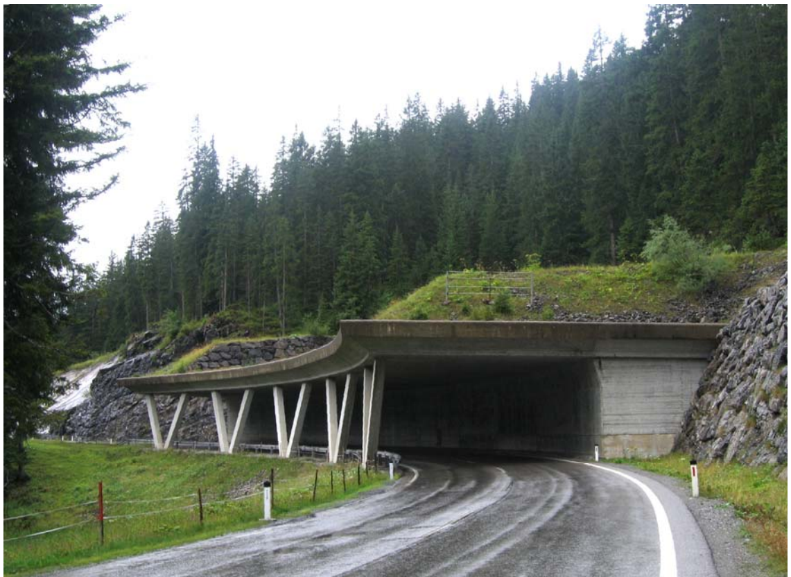
Cuneta, talús i fals tunel a Steeg (Voralberg, Austria)
