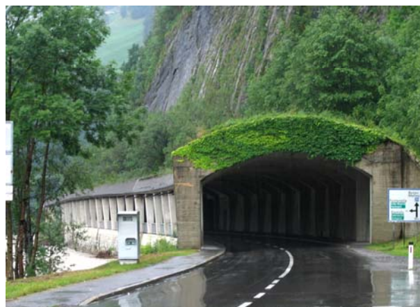
Fals túnel a Au (Bregenz, Austria)
