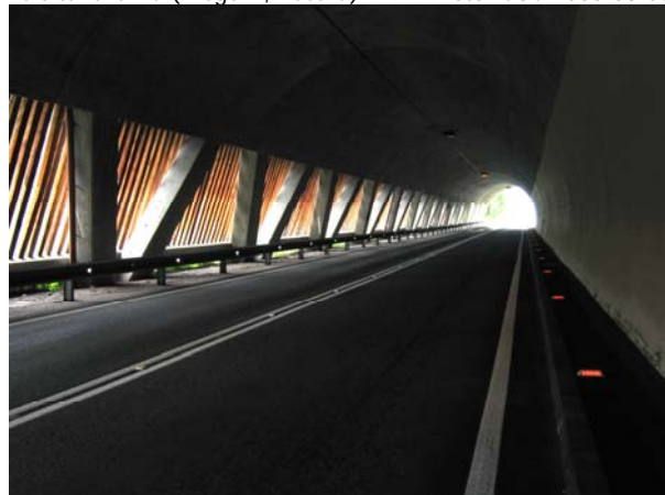
Fals túnel a Steeg (Vorarlberg, Austria)
